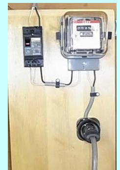
倉庫内に設置された「外部電源車用給電コンセント」にケーブルを差し込みます
